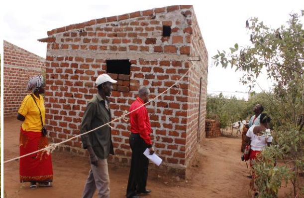
Membros da Plataforma monitorando as casas tipo-1 construídas para os reassentados no bairro Naverua-2
