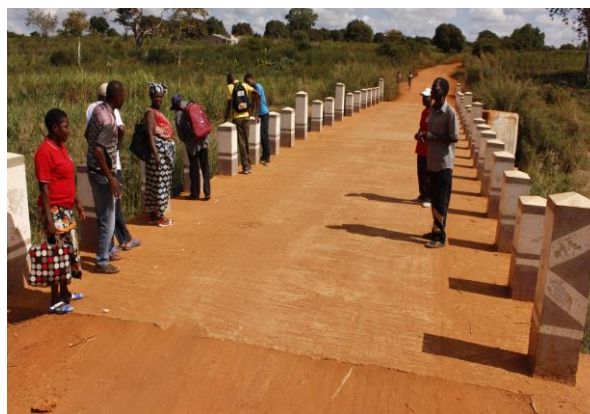
Membros da Plataforma, na recolha de evidências sobre a conclusão da ponte do rio Raraga.
