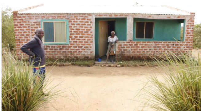
Monitoria das casas tipo-2 construídas para idosos no bairro de reassentamento de Mocuba Sisal
